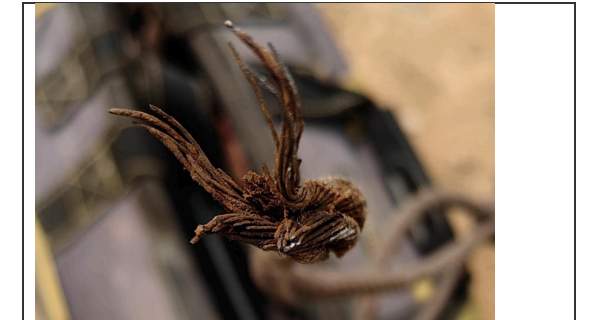
图11 东侧工作钢丝绳断口（俯视）
